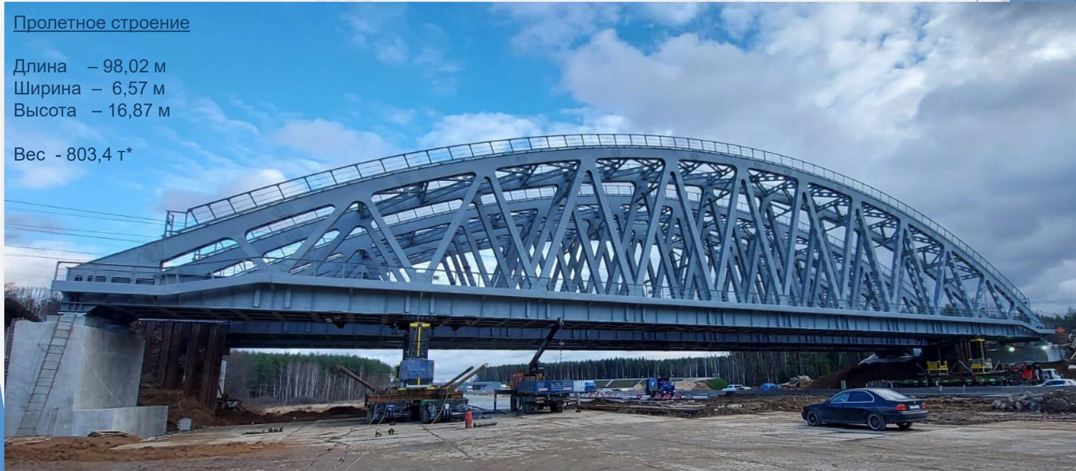
\*Примечание: указан вес пролетного строения вместе с установленными плитами БМП
