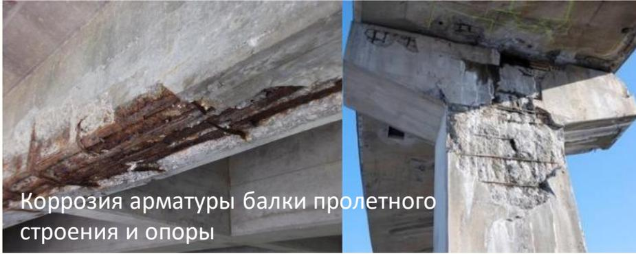
Коррозия арматуры балки пролетного строения и опоры
