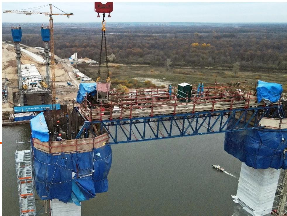
Конструкция опалубки имеет мостик соединяющий две опалубки стоек в одно целое
