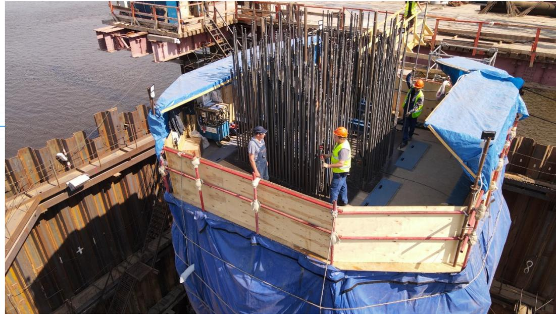
Густое армирование: на захватку высотой 1 м. объем армирования составляет 2,46 тн.
