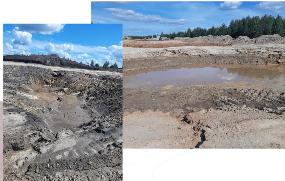
В ходе строительных работ происходит активизация карста. Образовались свежие провалы непосредственно на участках строительства земляного полотна.
